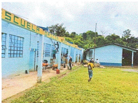
Foto1: Proceso de sustitucion de lamina en mal estado.
