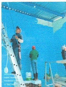
Foto 3: Aplicación de Pintura en paredes interior.
